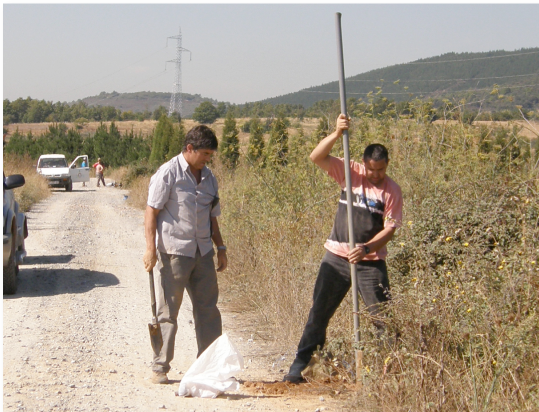
Figura 8.- Retacado del pozo una vez que ha sido cargado con el explosivo.
