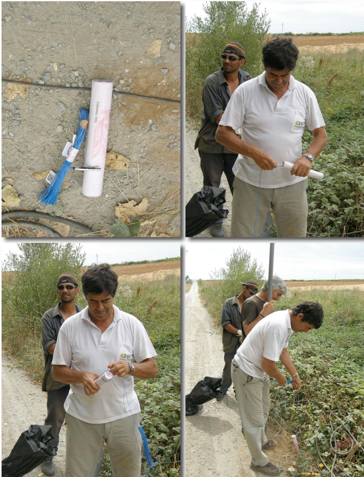
Figura 7.- Secuencia de preparación de la fuente sísmica. Arriba, a la izquierda, primer plano de un cartucho de explosivo y de un detonador sísmico; a la derecha, el detonador se introduce en el cartucho; abajo a la izquierda, el cable del detonador se anuda al cartucho para evitar que se suelte durante el descenso; abajo a la derecha, el cartucho y el detonador se introducen en el pozo.
